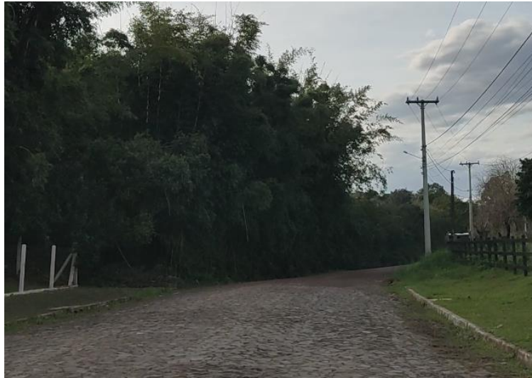
Foto 11: Final do trecho –Estaca 0+957
